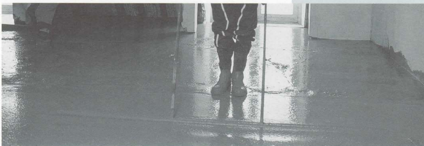
Ravoirage sous chape flottante et système de chauffage par le sol.
